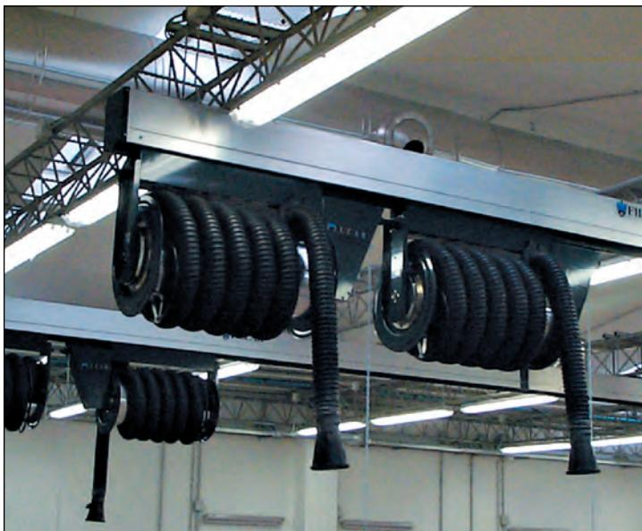
Canalina in alluminio con sezione 240 x 200 mm per alloggiamento di unità scorrevoli atte all'evacuazione dei gas di scarico e fumi dagli ambienti di lavoro.
